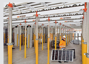
Опалубка для перекрытий
