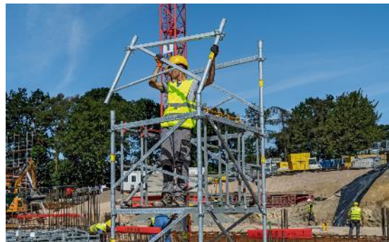
Демонстрация и обучение монтажу, демонтажу лесов и опалубки PERI на площадке клиента
