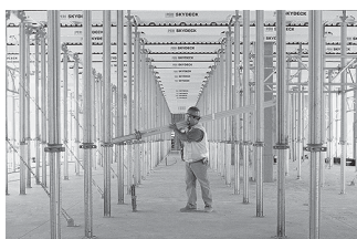
Опалубка для перекрытий
